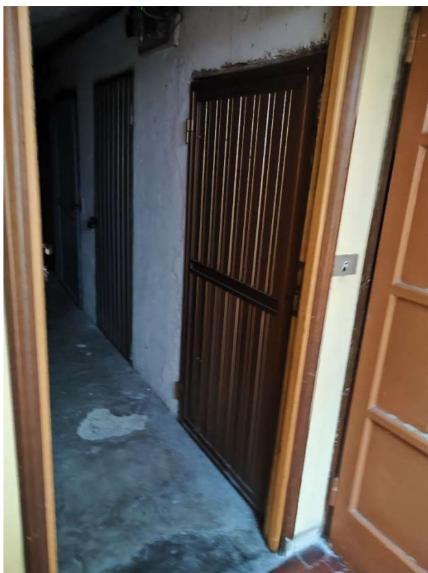
Foto n. 12 – Ingresso alla soffitta
