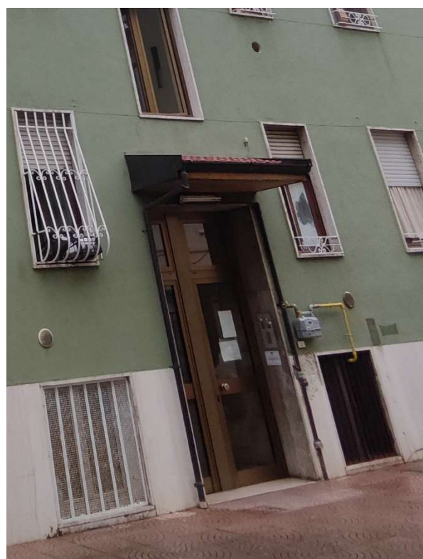
Foto n. 3 – Ingresso alla palazzina
